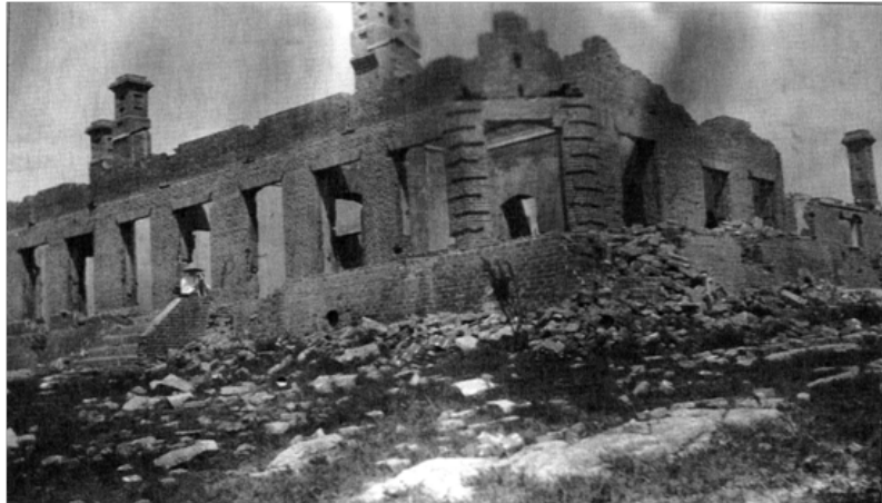
Один из домов А. Д. Старцева в Тяньцзине, разрушенный во время «боксёрского восстания» в 1900 г.
