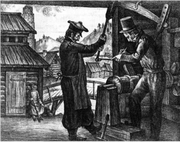
Н. Бестужев и К. Торсон за ремонтом тильной машины на Петровском Заводе. Фоторепродукция Ю. П. Павлова.
